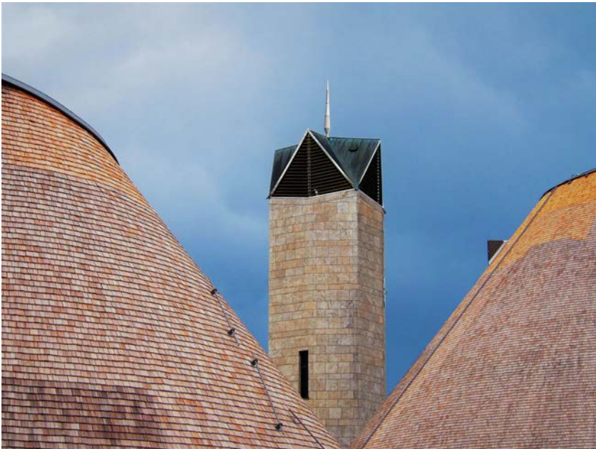
Der mehr als 50 Jahre alte Kirchturm, eingerahmt von den neuen Baukörpern der St.-Josefs-Kirche und der Kapelle Zur Heiligen Familie
