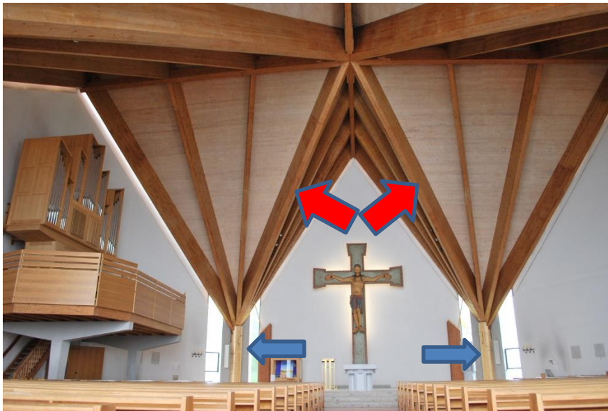
Blick auf zwei Stützpfiler (blau), die die Hohlkastenträger (rot) unterfangen
