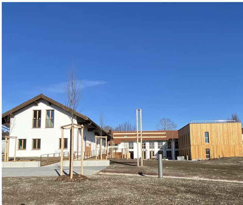
Foto: St. Josef Holzkirchen – Frisch renoviertes Pfarrheim und neues Verwaltungsgebäude (Irene Höfer) Einweihungsfeier am 27.04.2025
